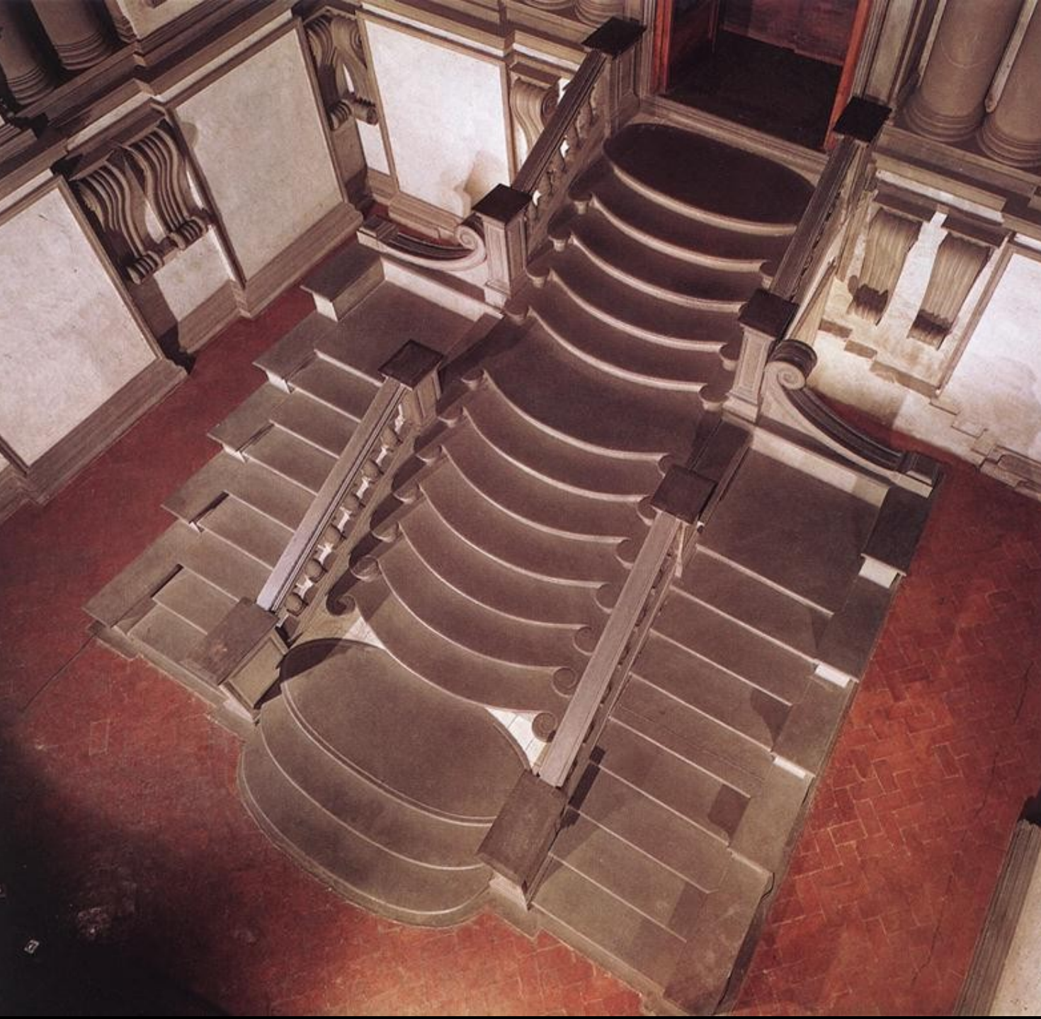
Escalera de acceso del vestíbulo (1530-1534)
